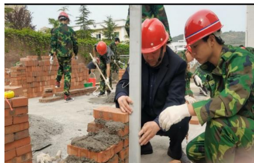
图 23 砌筑工培训实操现场教学
